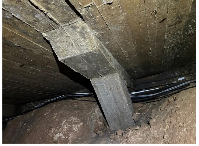
صورة رقم ٤: الممرات المعلقة و Corbels
